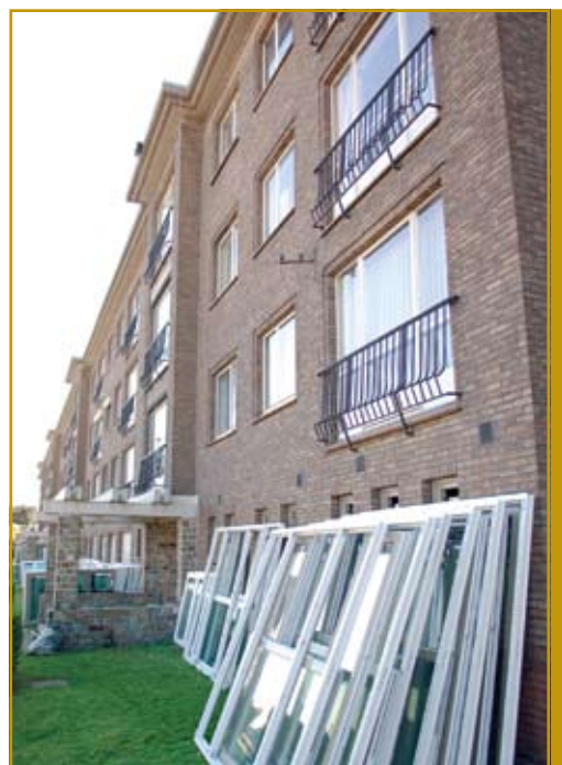
Woningrenovatie Orleanstraat (Meulestede)
