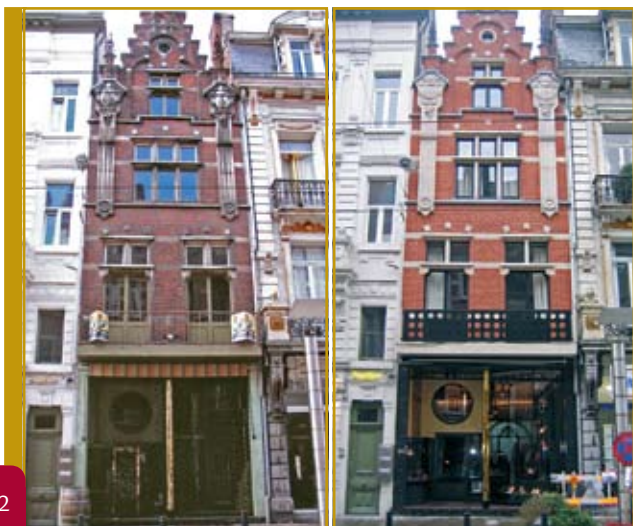
Voor en na de gevelrenovatie in de Vlaanderenstraat (Binnenstad)
